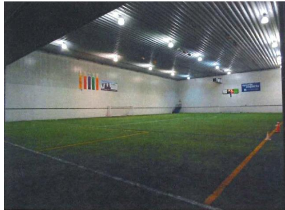
“HONCO” monocoque structure (Rosemère multisport centre – TX-36)
