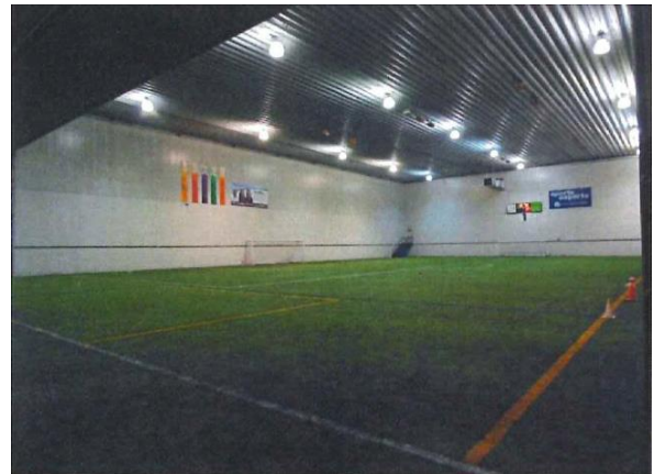
“HONCO” monocoque structure (Rosemère multisport centre – TX-36)
